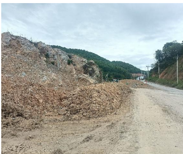
รูปที่ 2-4 การนำเปลือกดินจากการทำเหมือง ไปปรับแต่งคันทำนบดิน
