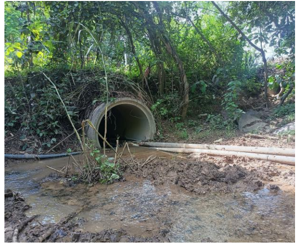
รูปที่ 2-32 วางท่อระบายน้ำลอดด้วยท่อคอนกรีตเสริมเหล็ก ห้วยแม่ยาก
